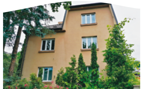
Výměna oken (FVS)
