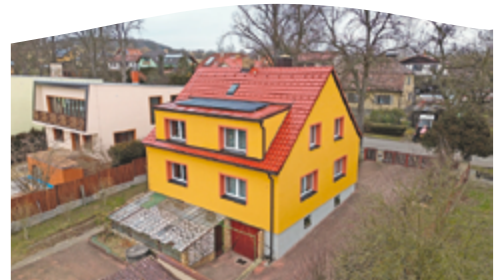
Zateplení fasády, výměna oken a dveří (FVS)
