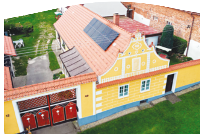
Solární fotovoltaický systém (FVS)
