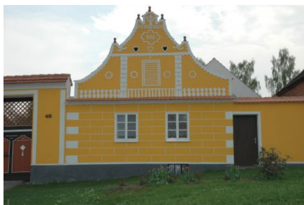
Lidová architektura (Hartmanice)
