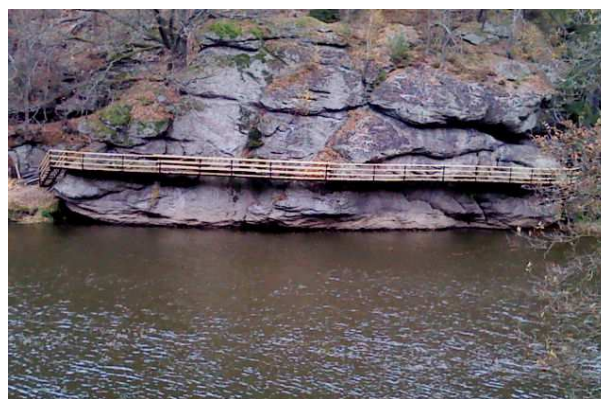
Opravená visutá lávka nad Lužnicí
