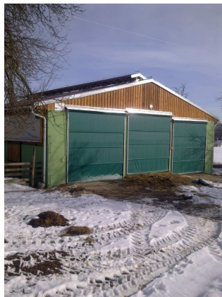
Novostavba výkrmny skotu (Bohunice)
