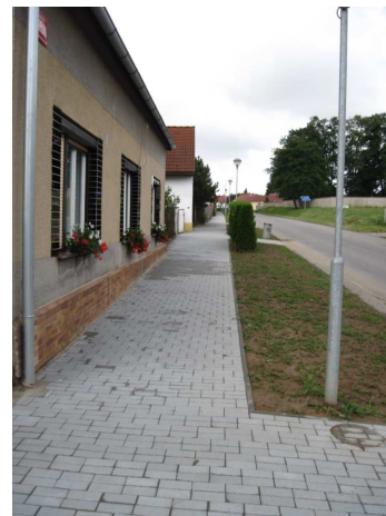
Rekonstrukce chodníků v Dolním Bukovsku
