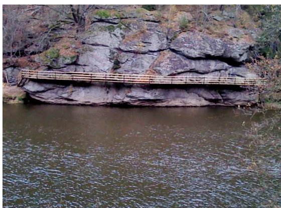
▲ Opravená visutá lávka nad Lužnicí
