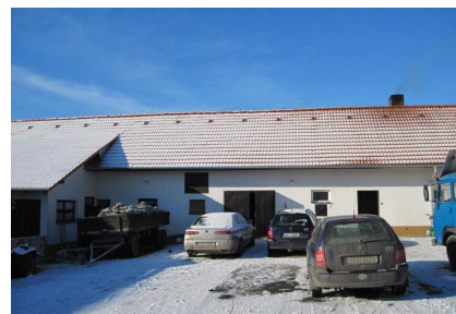
Rekonstrukce střechy hospodářské budovy zemědělské usedlosti (Sedlíkovice)
