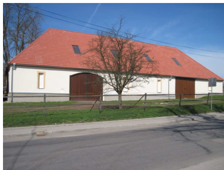
Rekonstrukce střechy hospodářské budovy v Týně n.Vlt. (v roce 2011 pak následovala fasáda)
