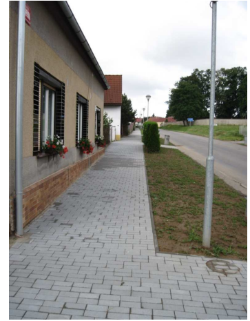
Rekonstrukce chodníků v Dolním Bukovsku
