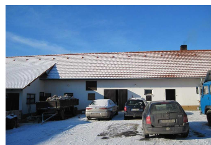
Rekonstrukce střechy hospodářské budovy zemědělské usedlosti (Sedlčovice)
