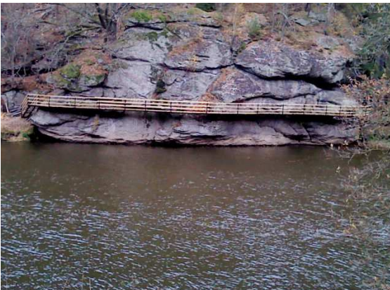
▲ Opravená visutá lávka nad Lužnicí
