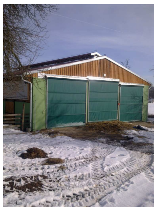
Novostavba výkrmny skotu (Bohunice)
