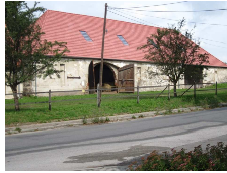
Rekonstrukce střechy hospodářské budovy v Týně n.Vlt.
