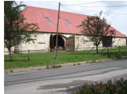
Rekonstrukce střechy hospodářské budovy v Týně n.Vlt.
