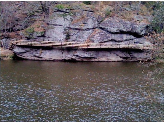
▲ Opravená visutá lávka nad Lužnicí
