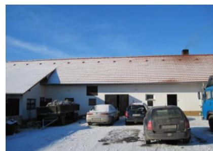
Rekonstrukce střechy hospodářské budovy zemědělské usedlosti (Sedlčovice)
