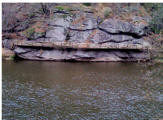
▲ Opravená visutá lávka nad Lužnicí
